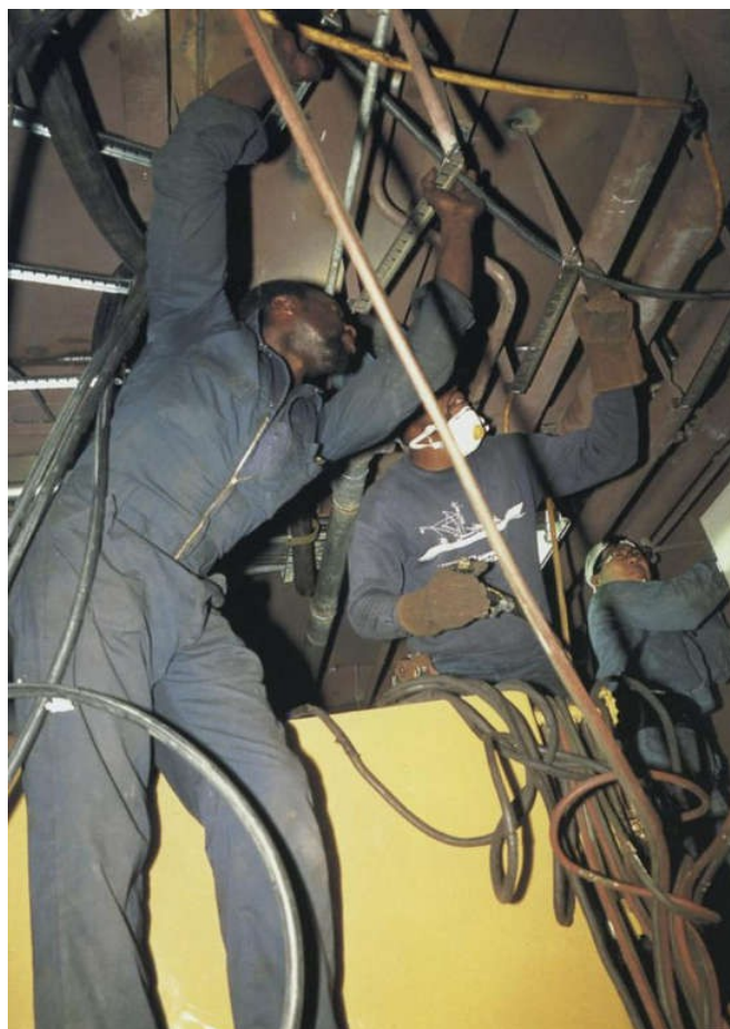
Photographie 1. Allan Sekula, Des tuyauteurs terminent la salle des machines d'un thonier. Chantiers navals Campbell. Port de San Diego, août 1990.
