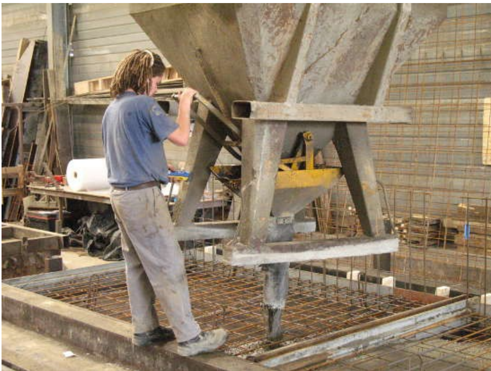
Photographie 7. Prefa 3 (Fabrication préfabriquée en béton)
