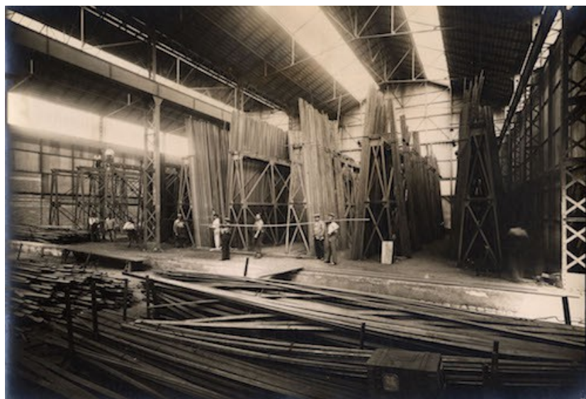
Photographie 1. Le « chantier fer » de l'entreprise Champenois.
